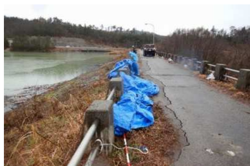
写真.1 被害状況(天端舗装のクラック)
